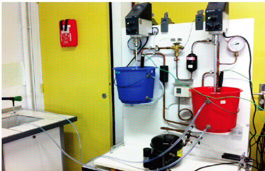
Figure 8 : Pompe à chaleur avec dispositif de refroidissement
